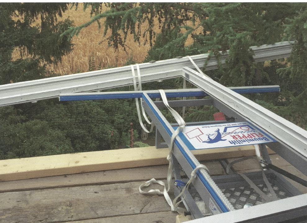
Die zusätzliche Schiene erleichtert das Handling großer Bauteile oder Scheiben. Fotos: Bau-Mini-Lift
